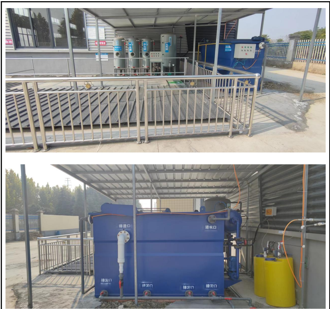
图 3-8 厂区污水处理站图
